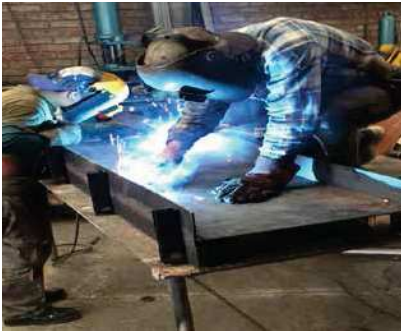
Fig. 18. Proceso de armado de vigas tipo I, con proceso de soldadura GMAW.
