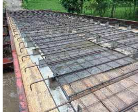
Fig. 21. Refuerzo para soportar cargas en losa.
