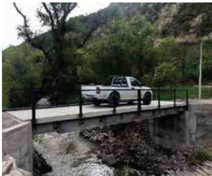
Fig. 24. Prueba de carga a los 21 días de edad del concreto con acelerante.
