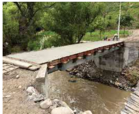
Fig. 22. Losa completa del tablero mixto.
