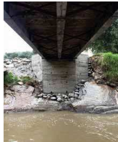
Fig. 23. Vista inferior del puente ya finalizado.
