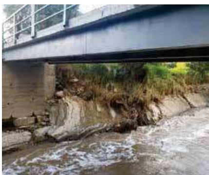
Fig. 25. Puente completo, donde se observa la linealidad de las vigas, donde la contraflecha sirvió para soportar los efectos constructivos de la losa de tablero.
