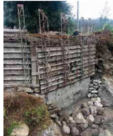
Fig. 16. Proceso constructivo de estribo de margen derecho aguas abajo, encofrado elevado.
