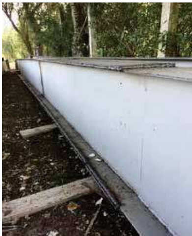
Fig. 19. Vigas armadas en obra, se observa en el borde superior la curvatura que es la contraflecha con la que fue armada la viga.
