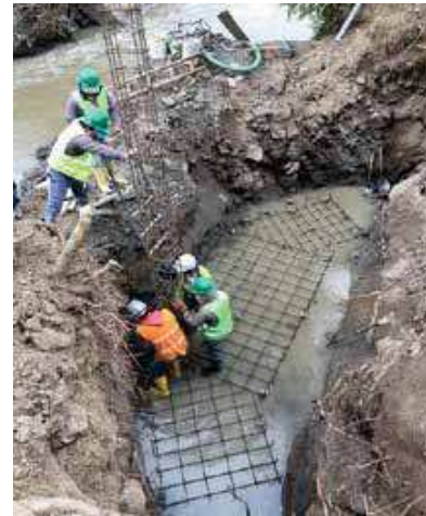
Fig. 15. Proceso constructivo de estribo, colocación de refuerzo.
