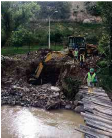
Fig. 13. Excavación del estribo izquierdo aguas abajo del puente.
