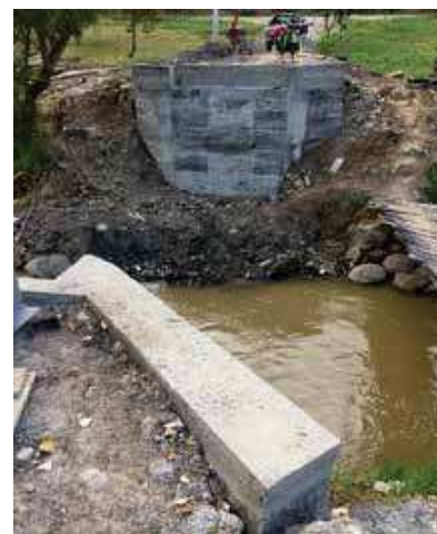
Fig. 17. Estribos finalizados.
