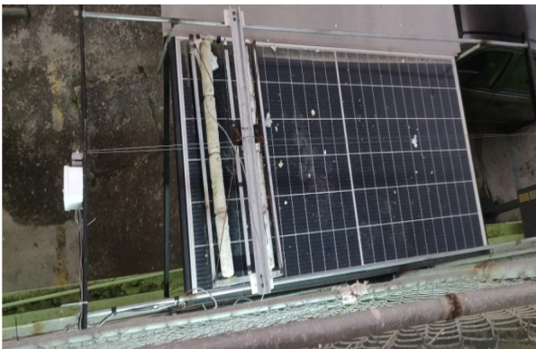
Fig. 11(a) Impurezas en la superficie del panel solar.
